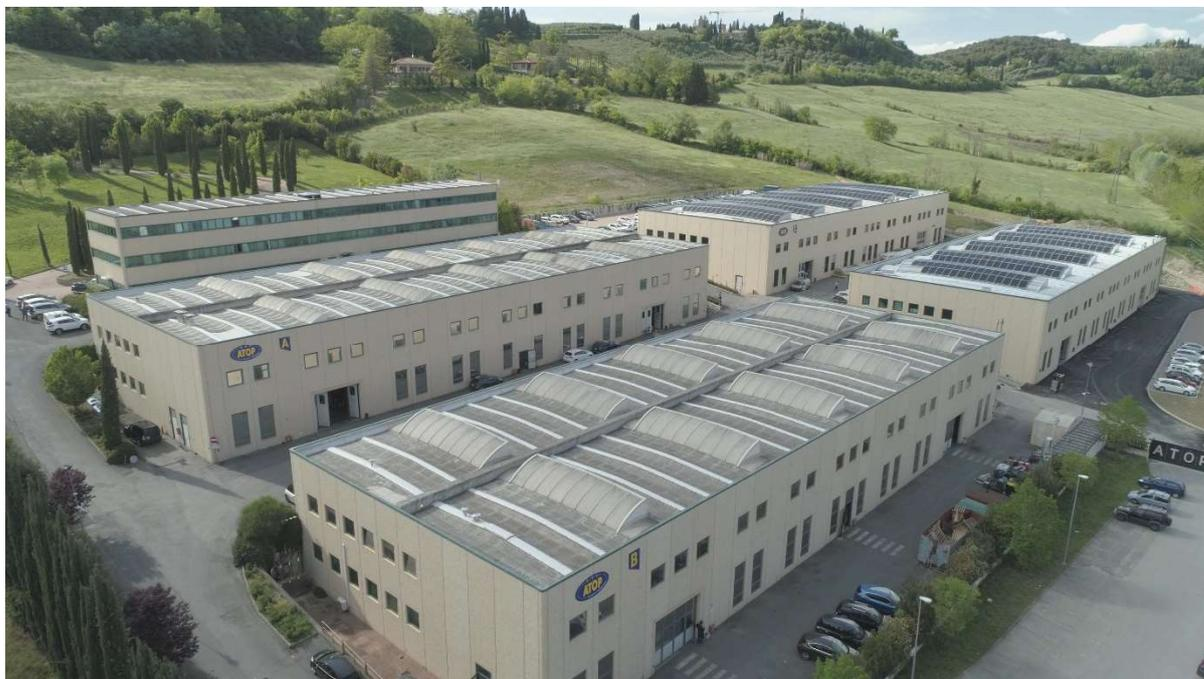
Le strutture portanti dei fabbricati che compongono lo stabilimento sono state realizzate in cemento armato e cemento armato precompresso ed i materiali di copertura e tamponatura sono in laterizio prefabbricato. È pertanto escluso l'impiego di materiali o sostanze pericolose o potenzialmente pericolose (es. amianto, ecc.). Al fine di rendere oggettiva tale valutazione sono stati esaminati gli elaborati progettuali e costruttivi afferenti i Fabbricati dell'Unità.
