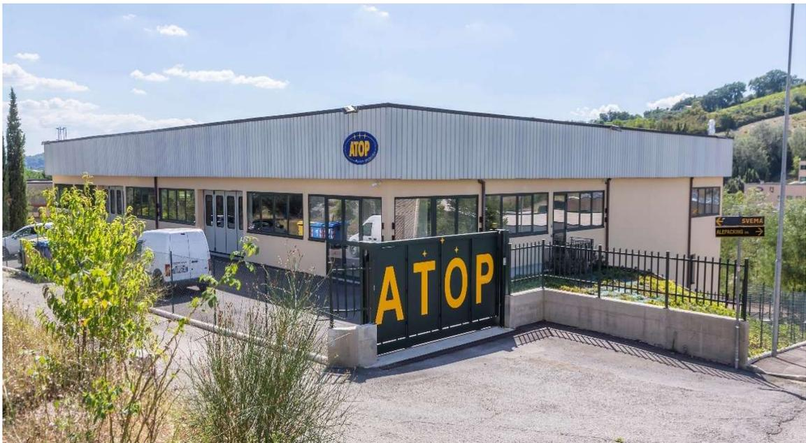
Le strutture portanti degli edifici dello stabilimento sono state realizzate in cemento armato ed i materiali di copertura sono effettuati con travatura in cemento armato e pareti di muratura in mattoni pieni e semipieni con apposita controsoffittatura dotata di materiali termo e fono isolanti. Le tamponature interne sono in cartongesso. L'edificio ha una porzione di proprietà Enel al piano seminterrato costituita dal locale cabina con una servitù di passaggio di cavi elettrici interrati.
